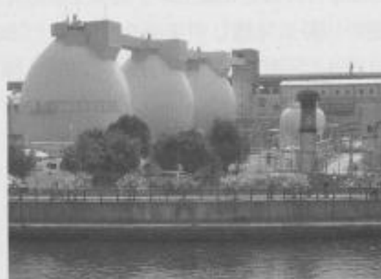
アーモンド並木と消化タンク
